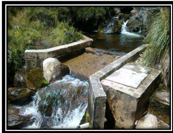
Ilustración 63. Bocatoma existente Acueducto Veredal de Las Vegas Chorreras
