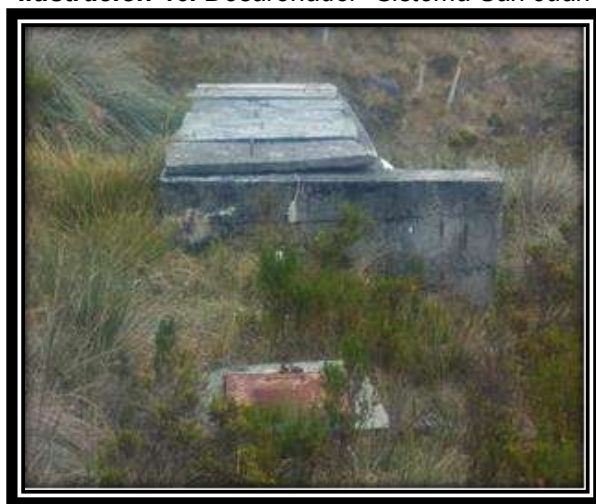
Ilustración 46. Desarenador- Sistema San Juan
