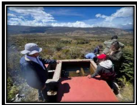
Ilustración 81. Tanque de Distribución existente Acueducto Veredal Plan de Sumapaz
