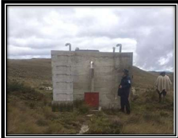
Ilustración 60. Tanque de Almacenamiento- Sistema Amigos del Páramo- Vereda San Antonio
