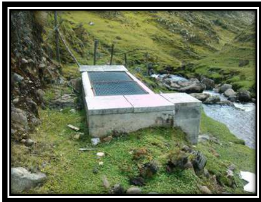
Ilustración 73. Desarenador existente Acueducto Veredal Tunales/ El Espejo
