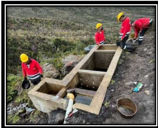
Ilustración 78. Desarenador existente Acueducto Veredal Plan de Sumapaz
