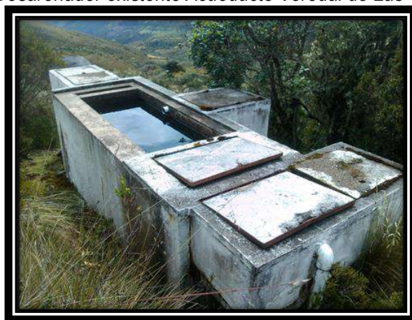
Ilustración 64. Desarenador existente Acueducto Veredal de Las Vegas Chorreras
