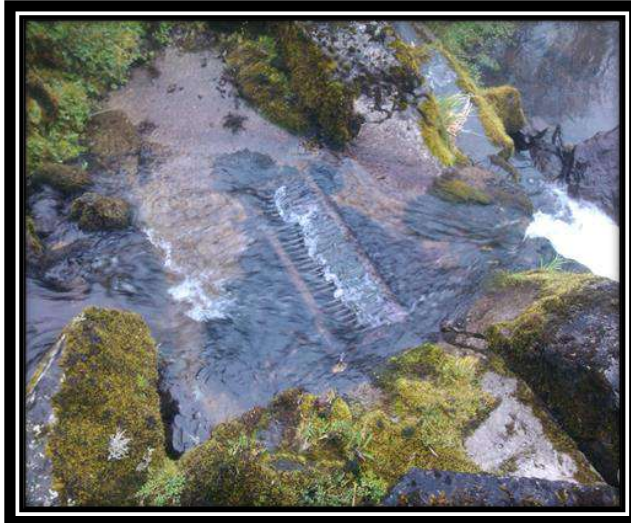
Ilustración 29. Bocatoma existente Acueducto Veredal ASOUAN
