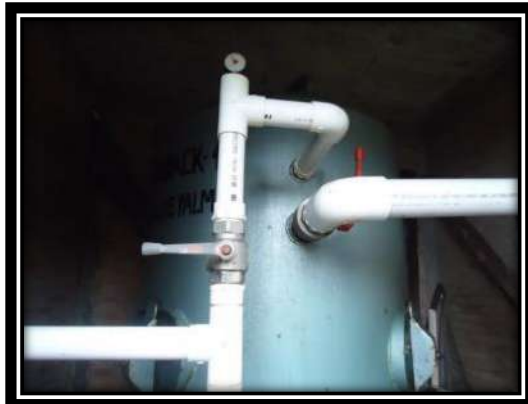
Ilustración 8. PTAP existente Acueducto Veredal Ríos- Las Palmas
