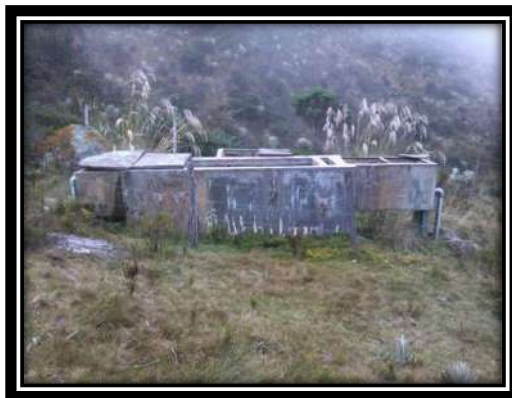
Ilustración 69. Desarenador existente Acueducto Veredal de Brisas del Gobernador
