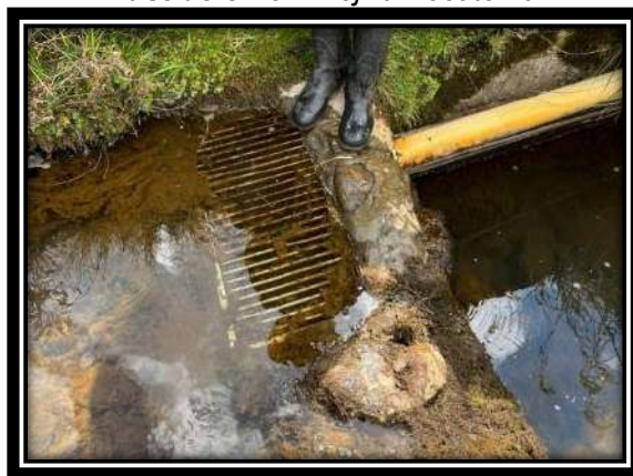
Ilustración 51. Rejilla Bocatoma
