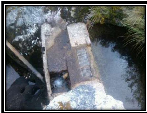
Ilustración 21. Bocatoma existente Acueducto ASOPERABECA II
