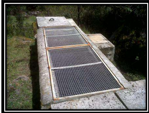
Ilustración 32. Desarenador existente- Sistema Taquegrande Acueducto Veredal ASOUAN
