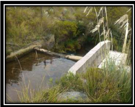
Ilustración 68. Bocatoma existente Acueducto Veredal de Brisas del Gobernador
