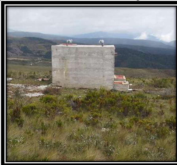
Ilustración 61. Tanque de Almacenamiento- Sistema Amigos del Páramo- Vereda El Toldo
