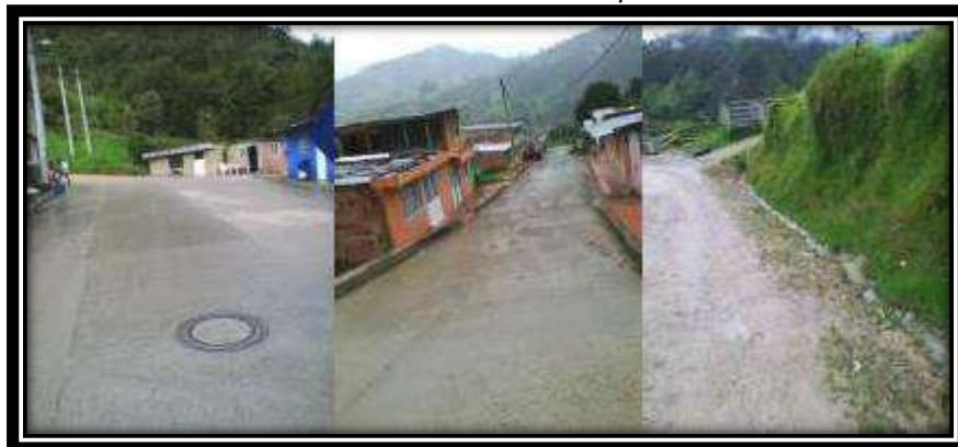
Ilustración 87. Alcantarillado centro poblado la Unión
