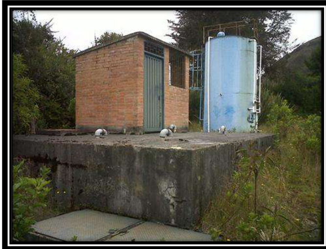
Ilustración 28. Tanque de Almacenamiento Acueducto Veredal ASOPERABECA III
