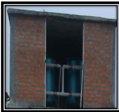
Ilustración 70. Planta de Tratamiento existente Acueducto Veredal de Brisas del Gobernador
