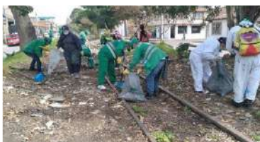
Intervención corredor férreo
