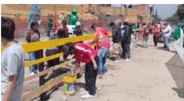
Intervención punto crítico malla del aeropuerto
