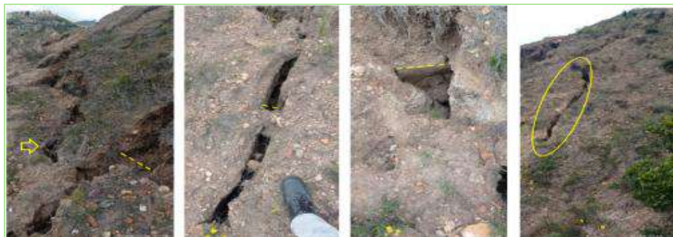
Ilustración 48. Grietas de tracción y procesos erosivos hídricos concentrados sobre las grietas identificadas en las bermas y taludes parcialmente reconfigurados
