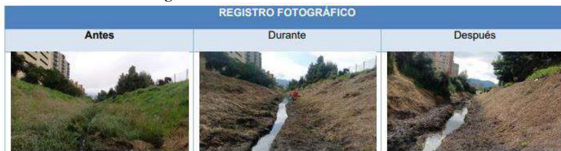
Imagen 2. Mantenimiento Canal Brazo Salitre
