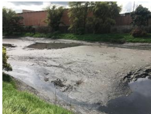
Foto 4: Colmatación de la laguna de sedimentación
