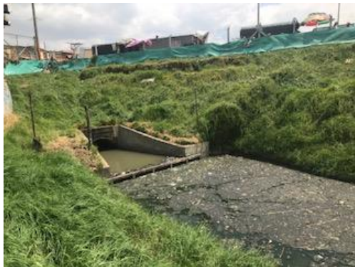
Foto 3: Contaminación hídrica por conexiones erradas
