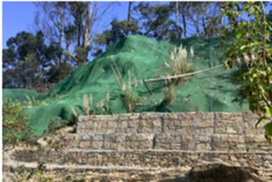
Obras de mitigación en parque Soratama Fuente: DGA – grupo de infraestructura
