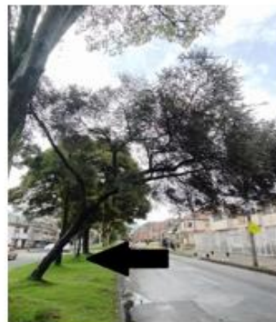
Emergencia por árbol en riesgo de caída
