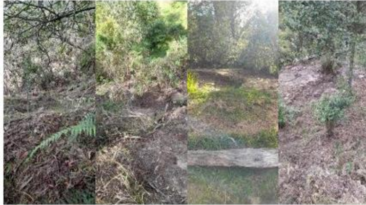
Ilustración 15. Registro fotográfico visita de verificación - Trabajos en ejecución Corinto
