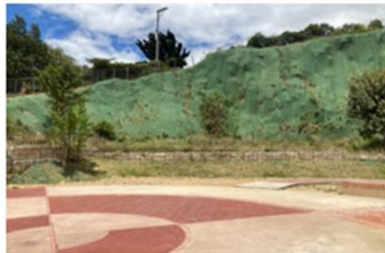
Obras de mitigación en Parque Mirador de los Nevados Fuente: DGA – grupo de infraestructura
