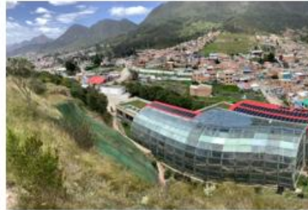
Aula Ambiental Juan Rey – Panorámica exterior Fuente: DGA – grupo de infraestructura
