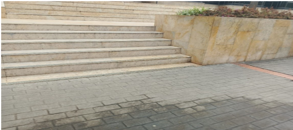
Imagen 1. Escaleras acceso principal sede central de la SDA
