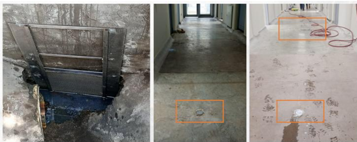
Imagen N°1 y 2. Instalación de Compuerta - Cambio de rejillas
