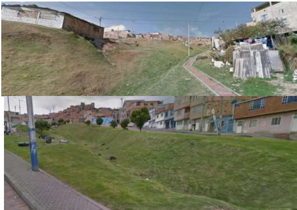
Figura 8. Registro Fotográfico Quebrada la Hoya del Ramo
