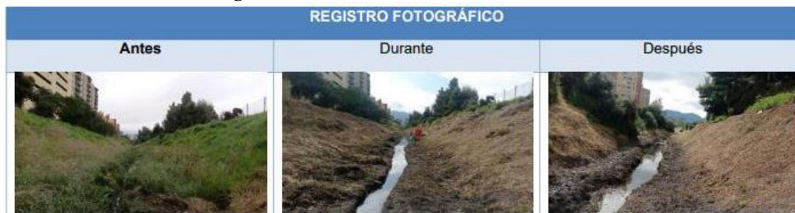
Imagen 2. Mantenimiento Canal Brazo Salitre
