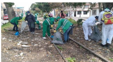
Intervención corredor férreo
