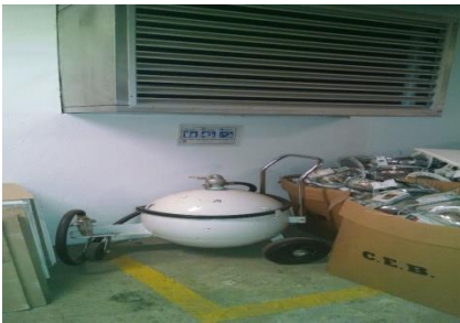
IMÁGENES DE PASILLOS Y SOTANO DE LA SDA.
