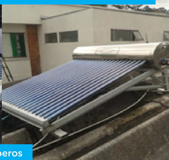
B-12 Candelaria 3 Calentadores de agua solares
