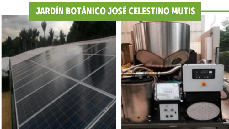
Equipos interconectados que suplen parte de la demanda eléctrica de la subdirección científica. Para su funcionamiento se utilizan los residuos de las podas del Jardín.
