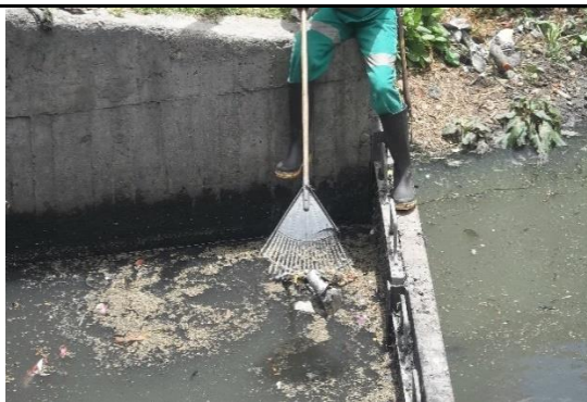
Foto 2: Presencia de grasas en el colector pluvial aferente
