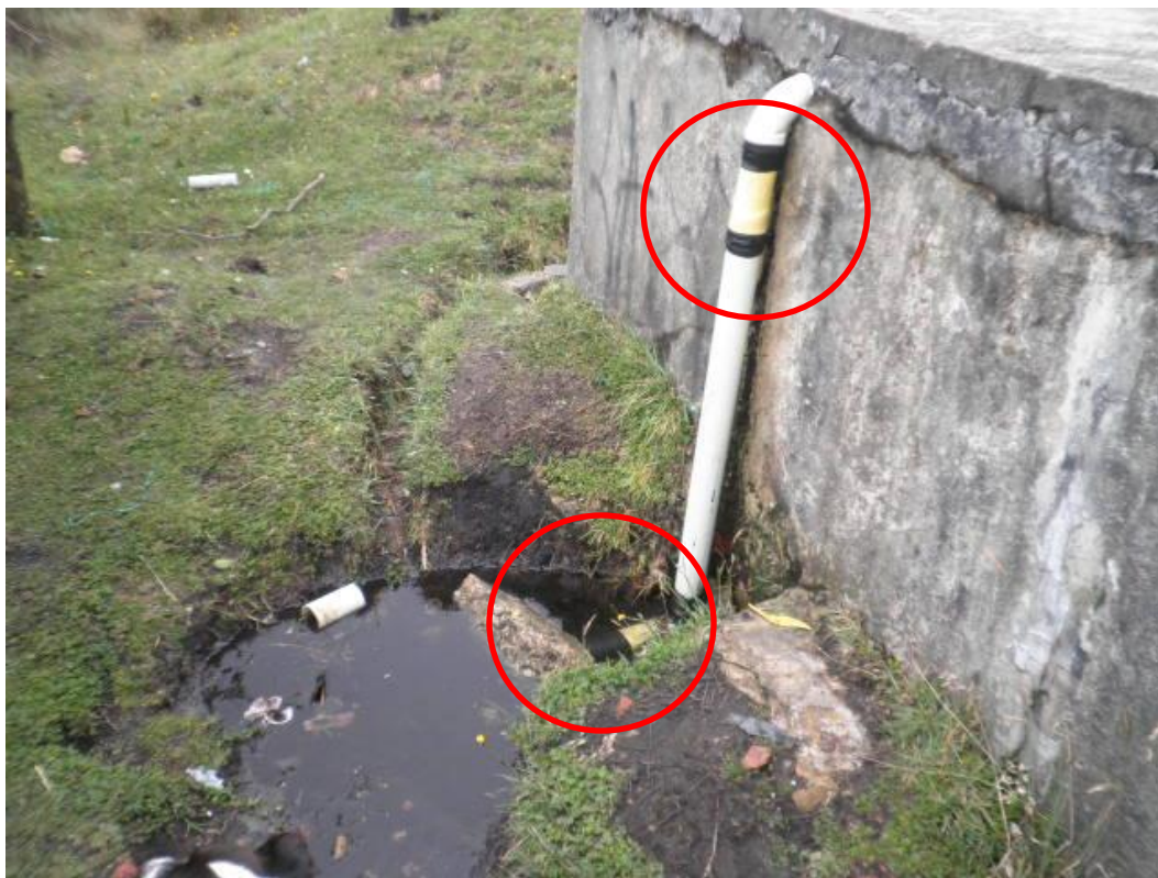
Foto 7. Se evidencian uniones y reparaciones en cinta aislante y daños sin arreglar que generan fugas
