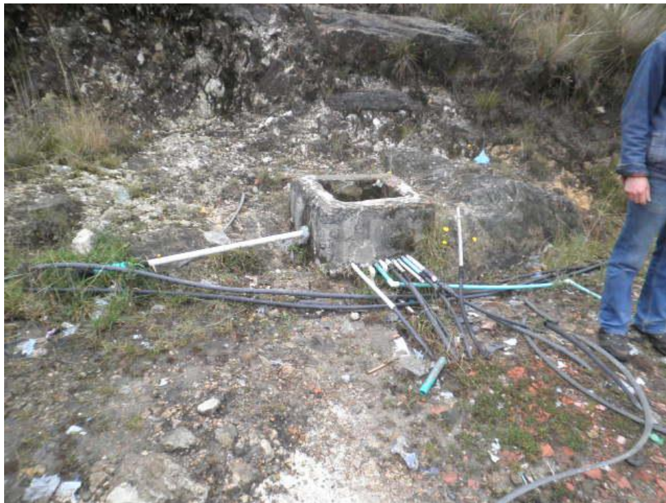
Foto 9. Se realiza distribución del agua por tuberías expuestas sobre la vía
