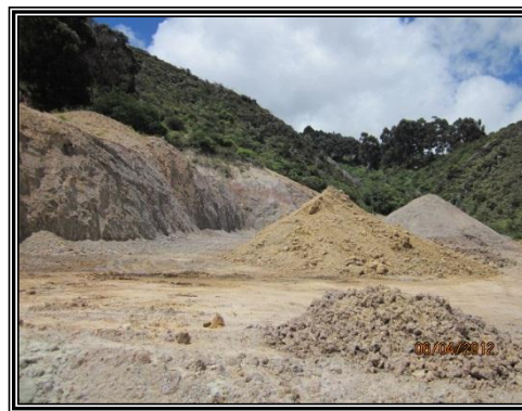
Fotografía No. 12. Industrias Gresqui Ltda. Panorama del frente minero sur, las pilas del material extraído y la invasión de la ronda Curí con dicho material.
