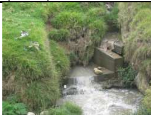
Fotografías del Punto Verificado
