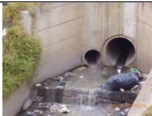
Fotografías del Punto Verificado
