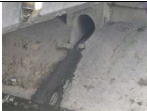
Fotografías del Punto Verificado
