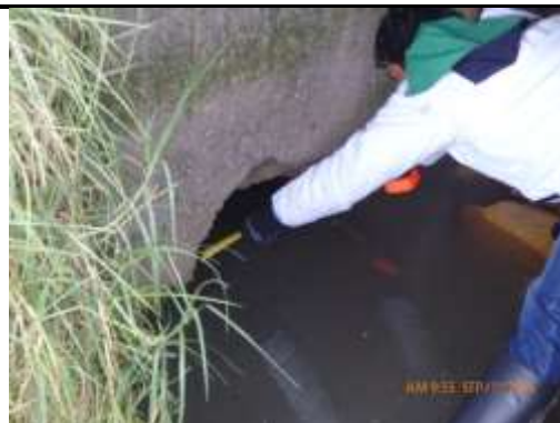
Fotografías del Punto Verificado
