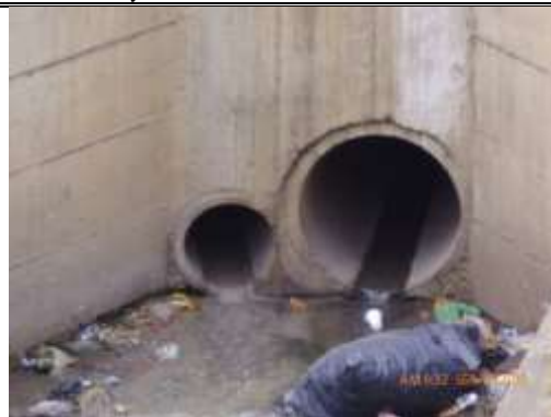
Fotografías del Punto Verificado
