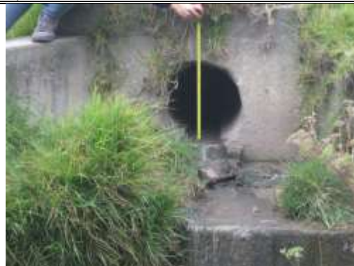
Fotografías del Punto Verificado
