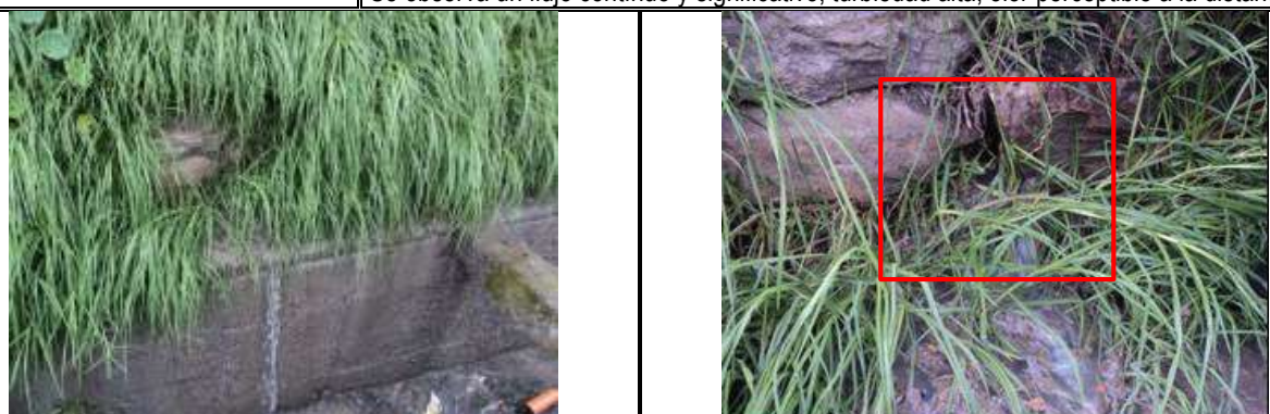
Fotografías del Punto Verificado
