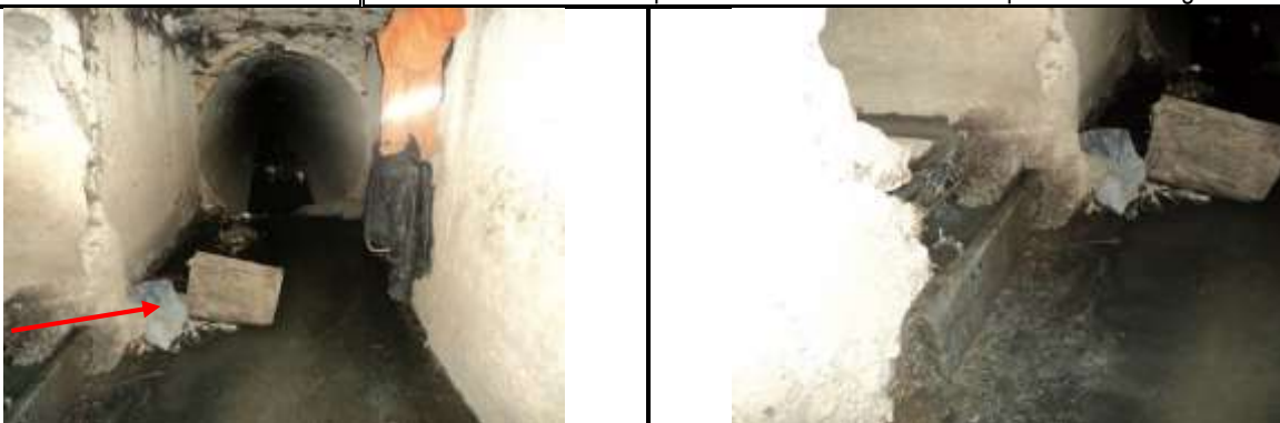
Fotografías del Punto Verificado
