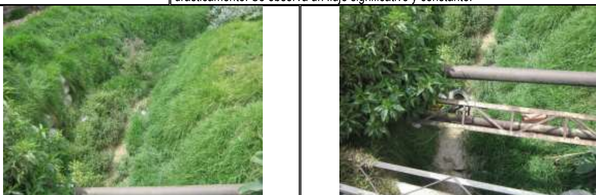
Fotografías del Punto Verificado
