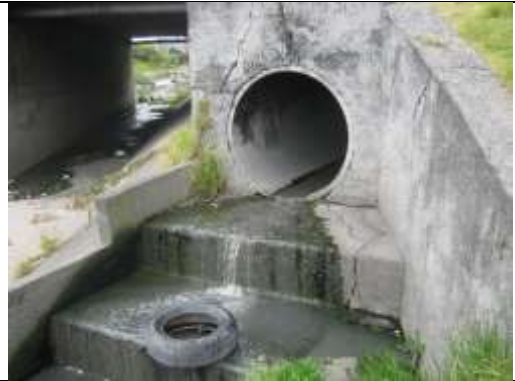
Fotografías del Punto Verificado
