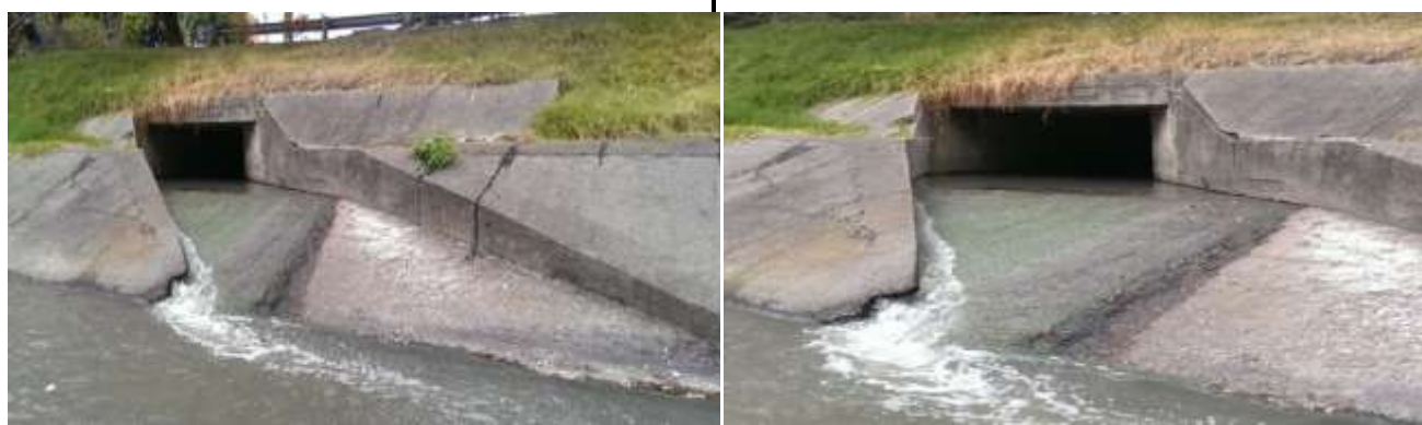
Fotografías del Punto Verificado
