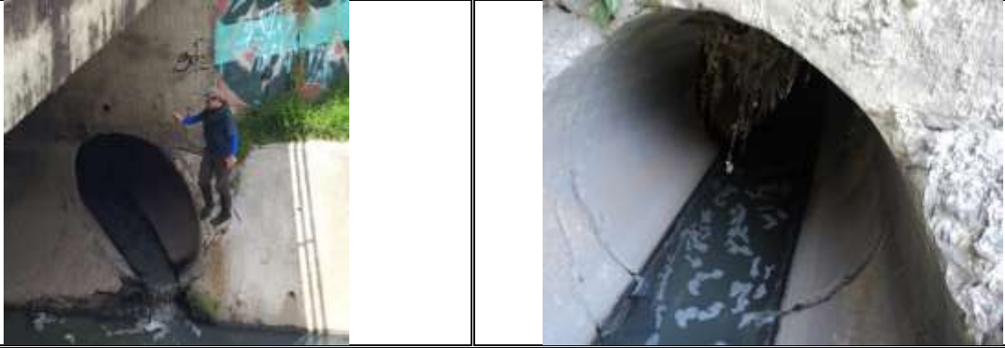
Fotografías del Punto Verificado
